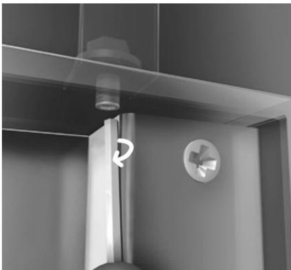
Abbildung 2: Position der Klemmstücke für den Blendrahmen
