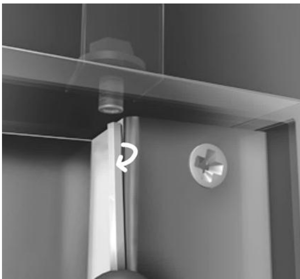
Abbildung 2: Position der Klemmstücke für den Blendrahmen
